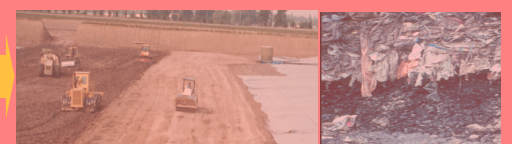
埋立廃棄物処分場と埋立地下の廃棄物
