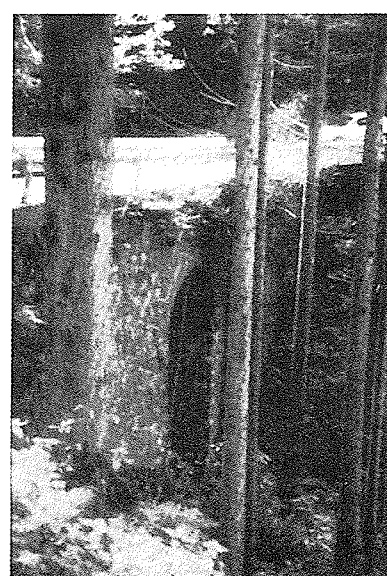
写真-8 槇山砲台跡地
