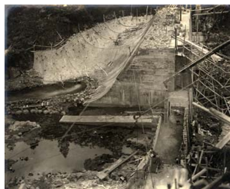
写真6 堤体中央部の排水路及び右岸側の様子
