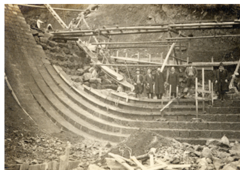
写真16 施工中の左岸側護岸
