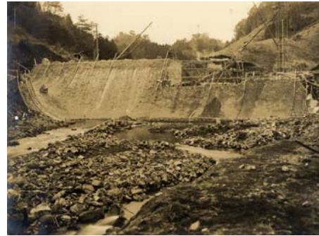
写真8 左岸側堤体の施工の様子
