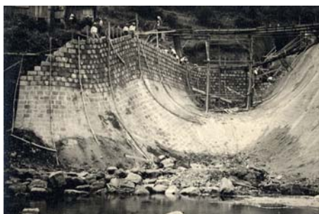
写真 11 右岸側護岸
