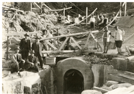
写真15 堤体右岸下流部排水路流出口
