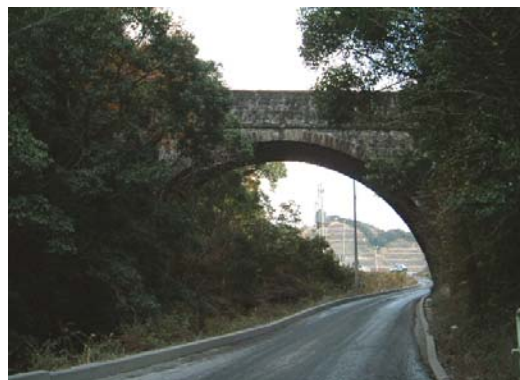
写真4 昭和井路水路橋（撮影：松尾，2003.12）
