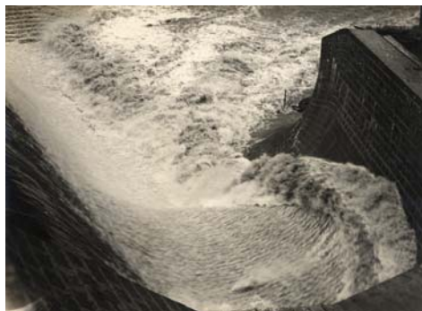
写真 12 右岸側護岸の水流
