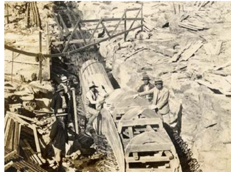
写真9 施工中の右岸側排水路
