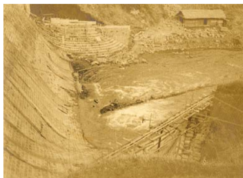
写真13 右岸側堤内排水路の流出口
