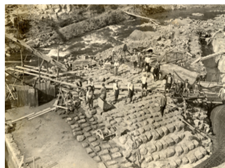
写真5 堤体右岸側内部
