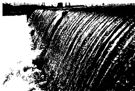
写真2 筋入り-布状-露出射流
