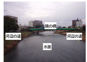
写真-5 G地点 (移動直角方向)
