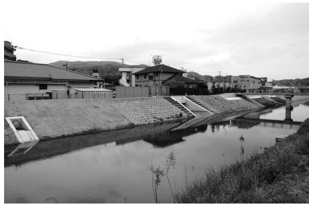
写真-2 対象河川施工完了区間
