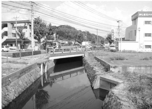
写真-1 対象地周辺の現在の様子
