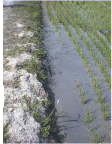
写真2 出水干拓の液状化
