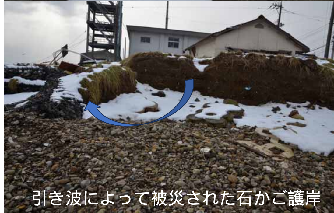
津波で破壊された堤防護岸
